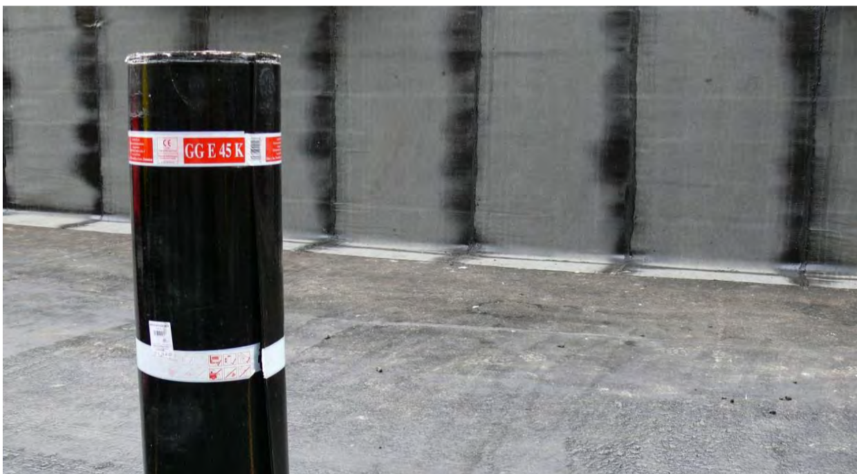
Apartmanház pinceszigetelése, Sárvár
