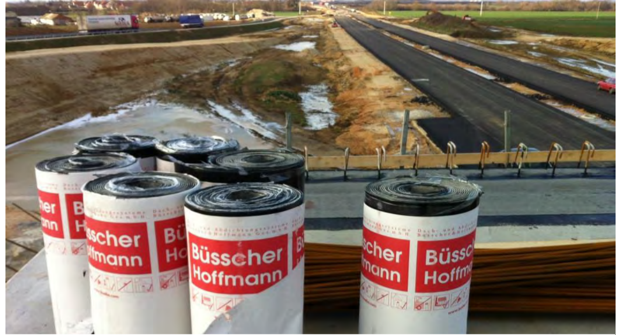
M35 hídszigetelés HÍD-2 rendszerrel
