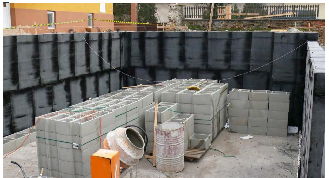
Apartmanház pinceszigetelése, Sárvár
