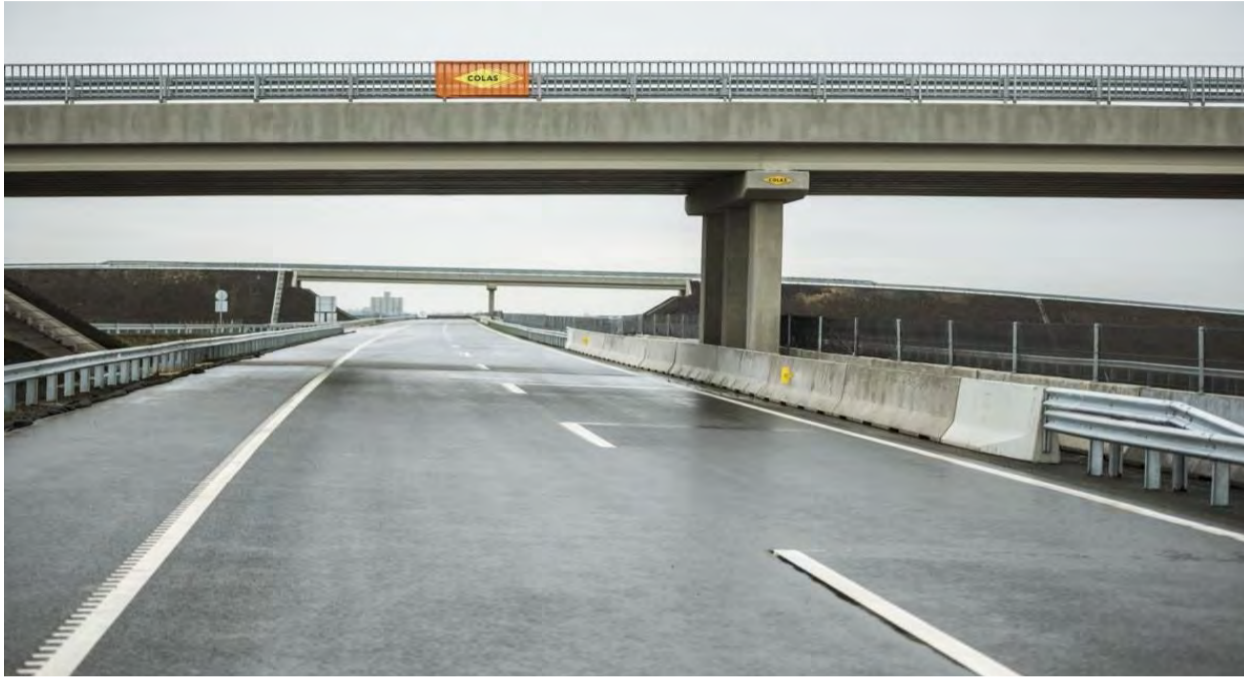
M86 hídszigetelés HÍD-2 rendszerrel
